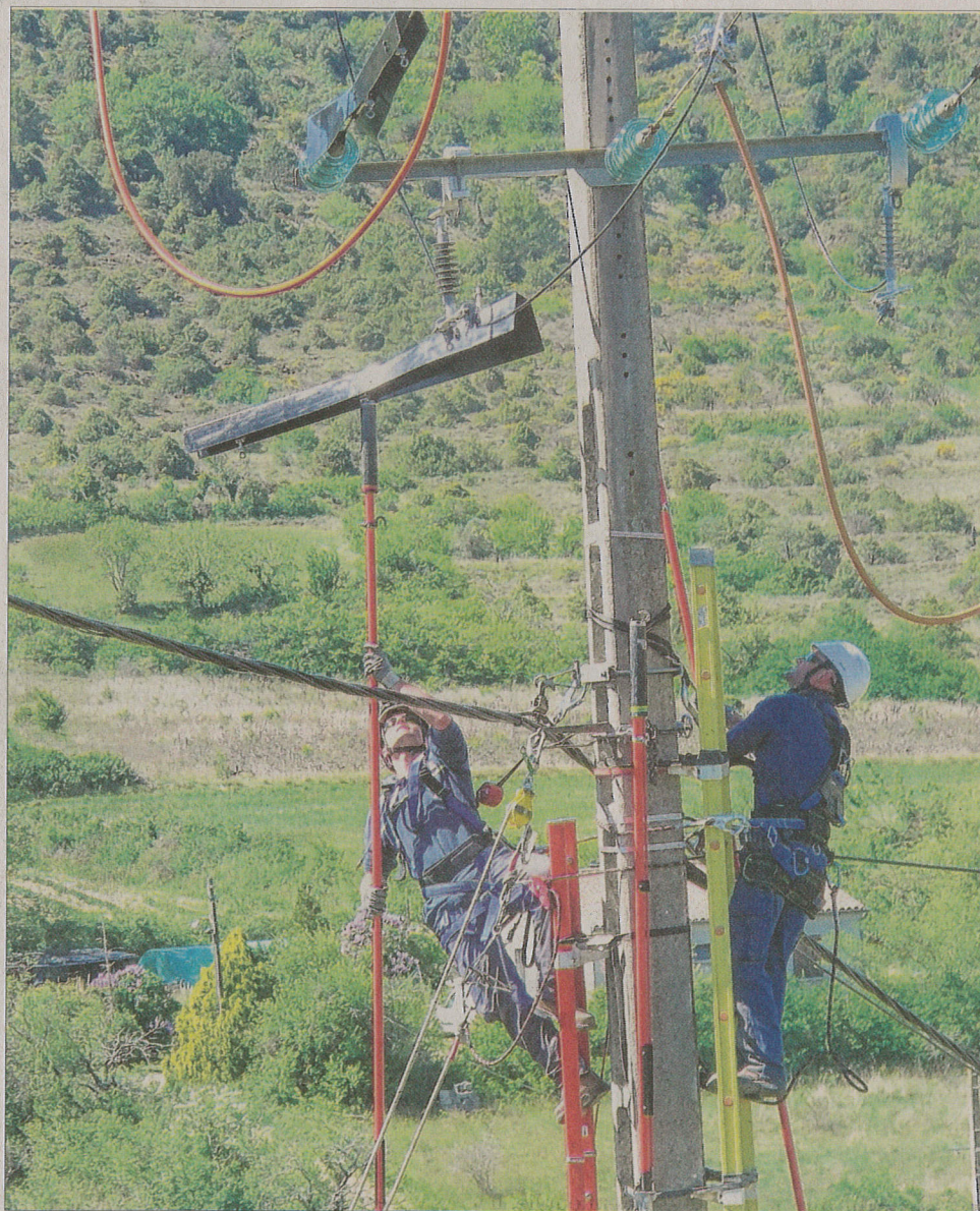
Une opération délicate qui nécessite de la dextérité. Au bout de la perche isolante, des protections pour que les oiseaux puissent se poser, à la grande satisfaction de Michel Mure, chargé de mission à la Ligue pour la protection des oiseaux.
